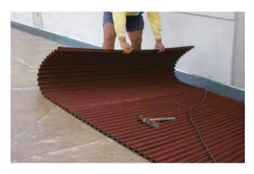
Gracias a su gran flexibilidad y a su fijación mecánica, se absorben los movimientos estructurales y las dilatacionescontracciones, sin roturas.
