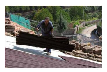
Las placas Onduline Bajo Teja DRS pesan solamente 3Kg/ m<sup>2</sup>, factor muy importante en rehabilitación. Se evita la sobrecarga en estructuras tanto antiguas como nuevas, permitiendo trabajar con mayor seguridad.
