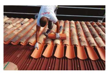
Las placas Onduline Bajo Teja DRS ofrecen una plantilla que facilitan la colocación de las tejas curvas. No es necesario calzarlas y **la cubierta se realiza en seco**, con gancho y espuma, evitando el uso de mortero.
