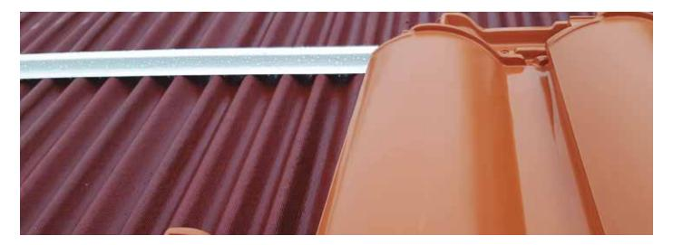
Obligación de impermeabilizar el soporte por debajo de unas pendientes mínimas, en función del tipo de teja utilizada.
