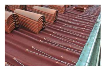
La rugosidad junto con la composición asfáltica y su formato onda-plano proporciona un **agarre natural de las tejas curvas**, reduciendo en gran medida la necesidad de material de agarre.
