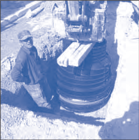
8 Rematarlo con el cono de reducción.
