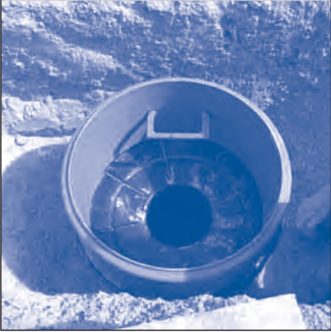
6 Montar el cuerpo de pozo con su junta de goma.
