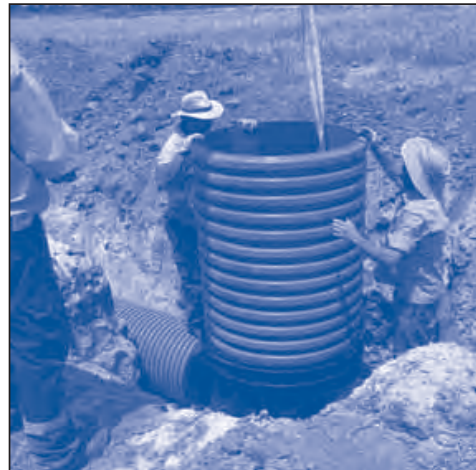
9 Colocar el cuerpo del pozo.
