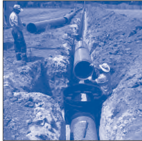
7 Bajar el siguiente tubo a la zanja.
