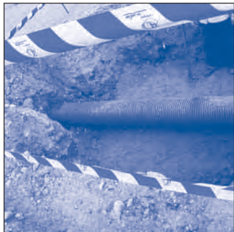
2 Tuberías ya instaladas en línea.
