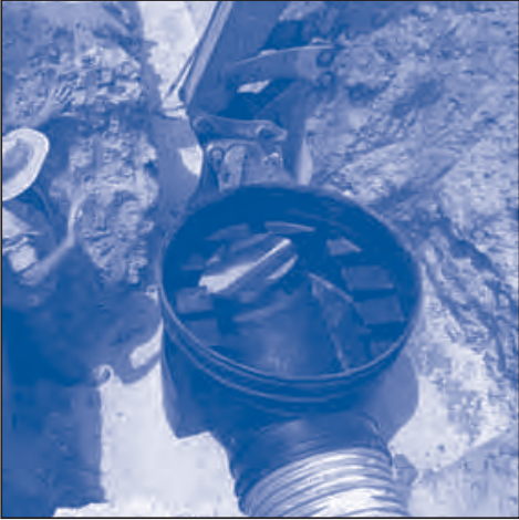
6 Con ayuda de una maquina introducir el entronque en el tubo.
