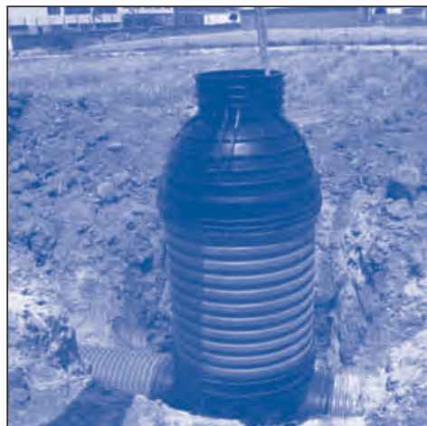
10 Montar el cono y tapar, compactando el terreno por tongadas.
