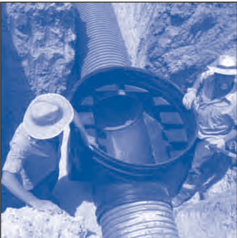
8 Lubricar de nuevo, e introducir el tubo.
